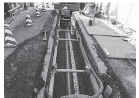
▲汚水管復旧工事（敷設状況）
