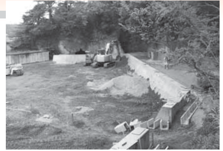
▲ 宅地の造成工事が進んでいます (野々島・ブルーセンター背後地)
