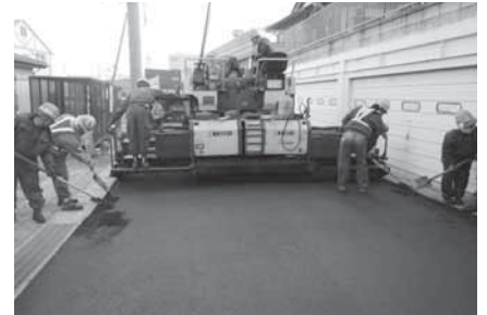
▲道路復旧工事（藤倉3丁目）
