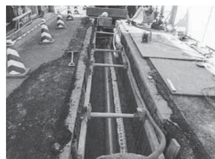
▲污水管復旧工事（敷設状況）
