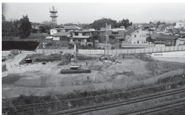
災害公営住宅整備事業（錦町）
