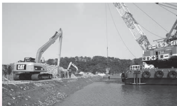
寒風沢漁港の護岸工事（浦戸寒風沢）
