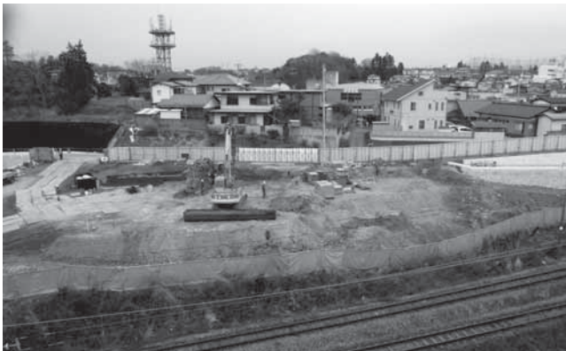
災害公営住宅整備事業（錦町）
