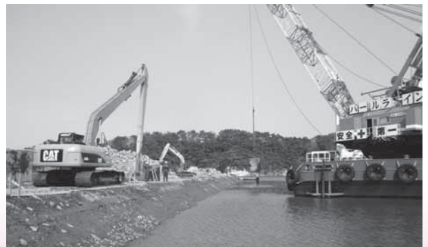
寒風沢漁港の護岸工事（浦戸寒風沢）
