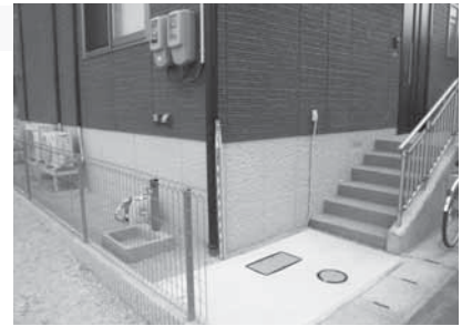
▲ 高基礎工事の例 (北浜一丁目)
