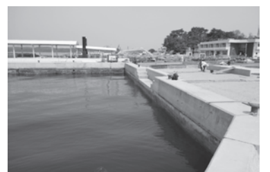
▲工事が進む漁港施設 (野々島)
