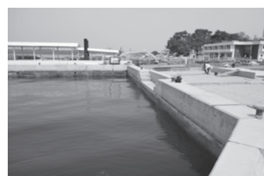
▲工事が進む漁港施設（野々島）
