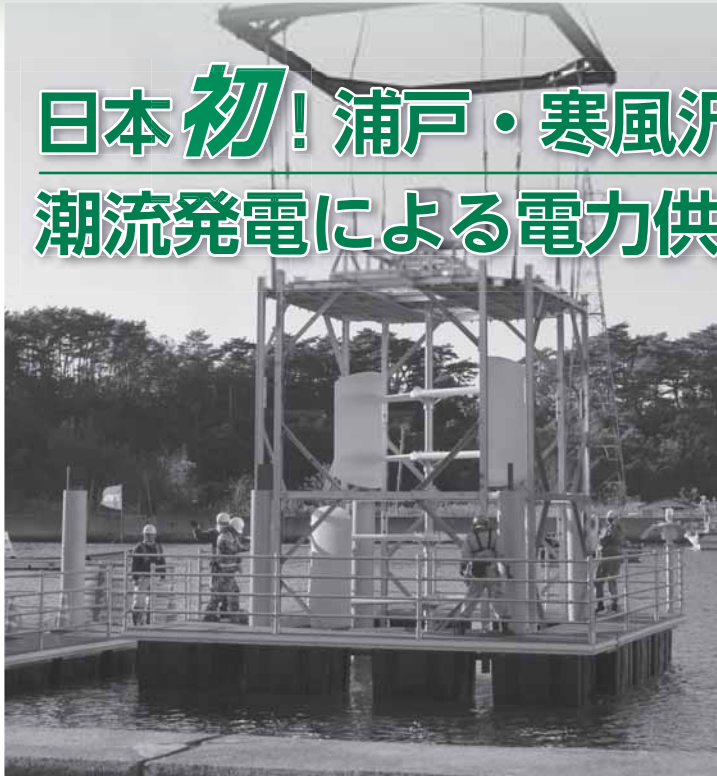
▲寒風沢水道に設置された潮流発電装置
