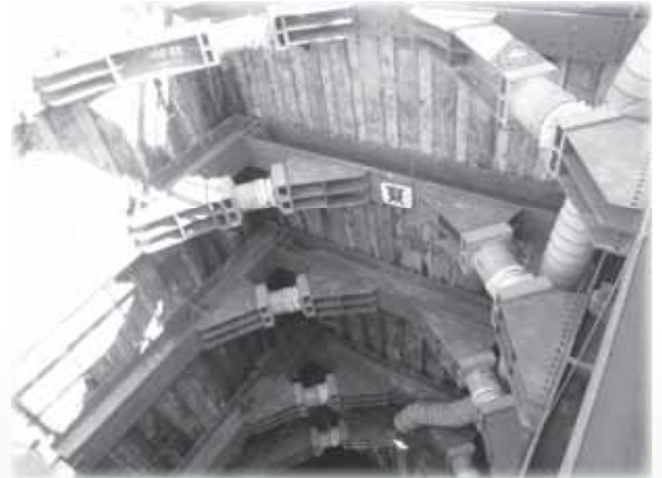
▲発進立坑から地下15メートルへ
