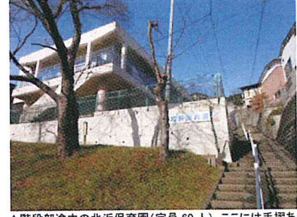
▲階段部途中の北浜保育園(定員 60人)。ここには手摺あり
