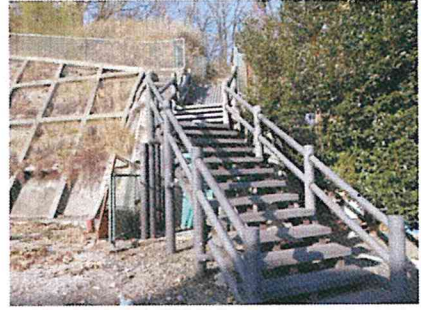
▲避難路入口部分の階段
