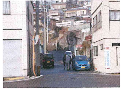
▲国道45号からの避難路の入口部分
