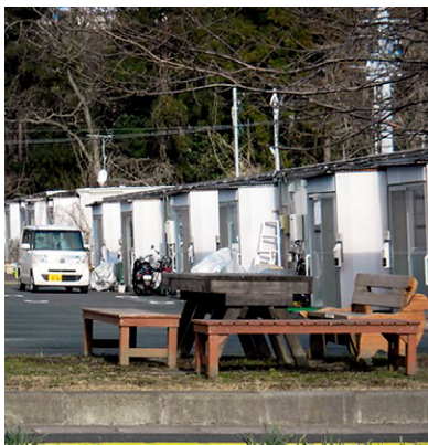
応急仮設住宅（伊保石ステーション）
