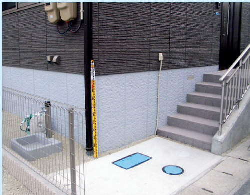
高基礎工事の例（北浜一丁目）
