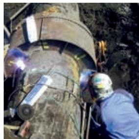
破損した鋼管の溶接作業
