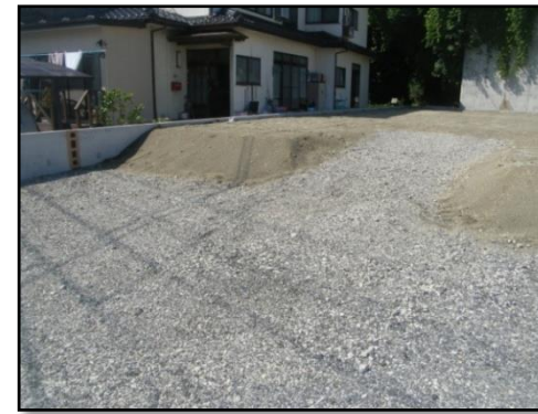
かさ上げ工事 + かさ上げに伴う擁壁工事(藤倉二丁目)
