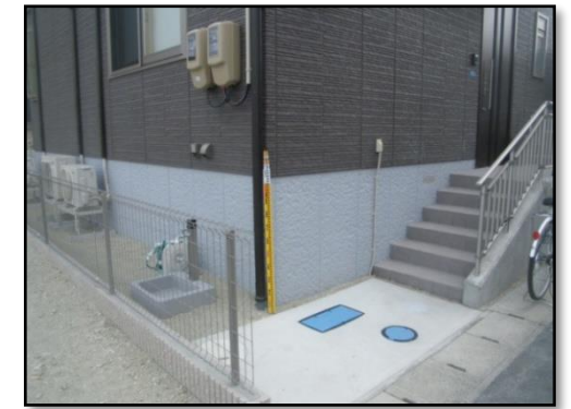
高基礎工事(北浜)
