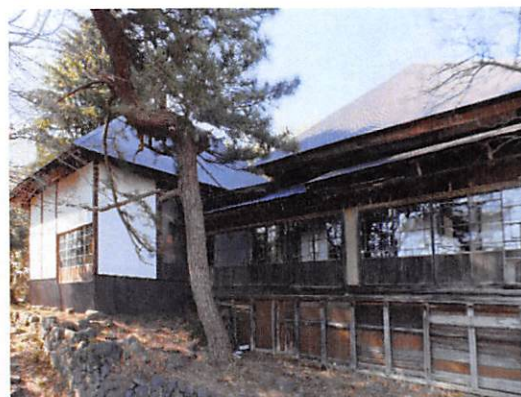
外壁・窓ガラス等の補修
