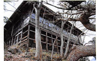
懸けづくり部分 （応急修繕工事前のようす）
