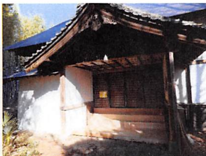
式台部分の仮復旧、鍵設置
