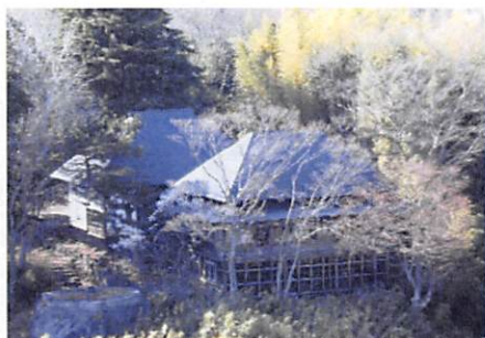
屋根の改修（鋼板敷設）
