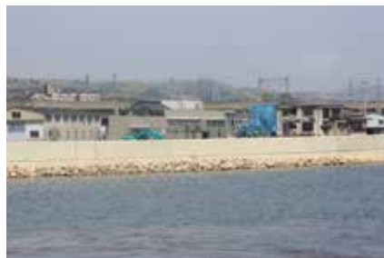
現在 緑地護岸 整備中
