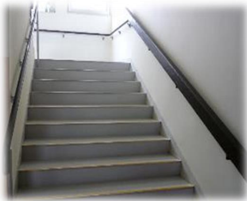
(階段床の塩ビシート張替え)
