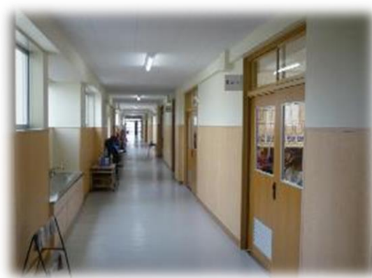
（腰壁の張替えと腰壁上部の塗装、床の塩ビシート張替え）
