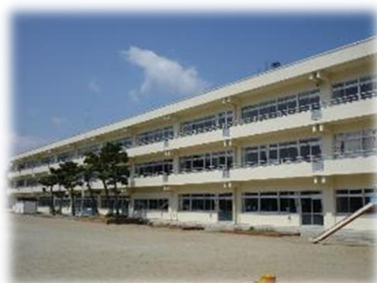
（外壁の亀裂補修、塗装仕上げ）
