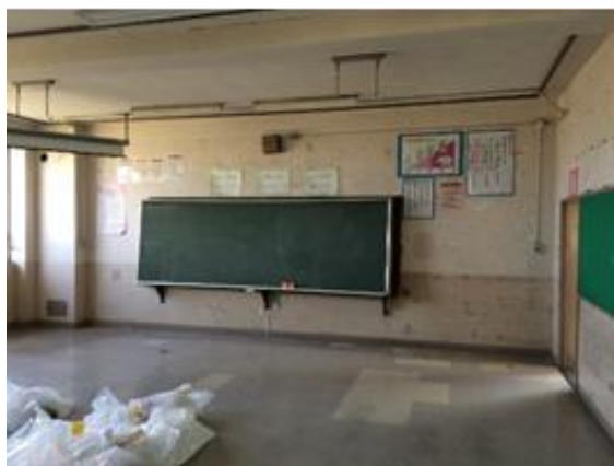
△ 2 号校舎 着工前内観（内装改修）
