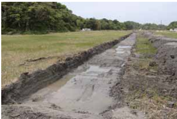
T 5 トレンチ（南東から）
