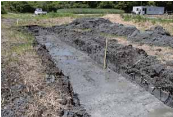
T 3 トレンチ全景（東から）
