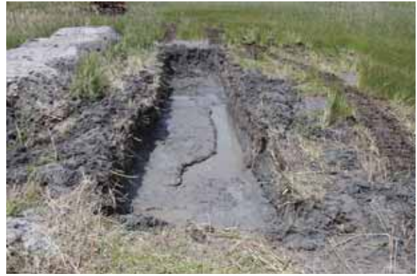
T25 トレンチ（東から）
