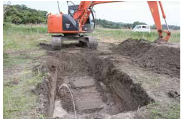
T26 トレンチ全景（南から）
