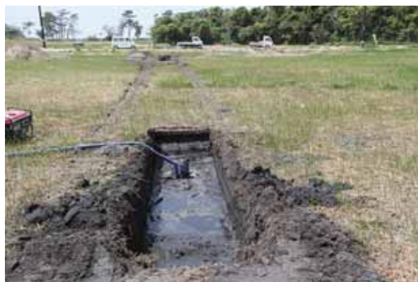
T 8 トレンチ全景（東から）
