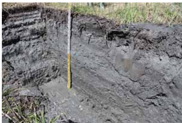
T2 トレンチ全景（東から）
