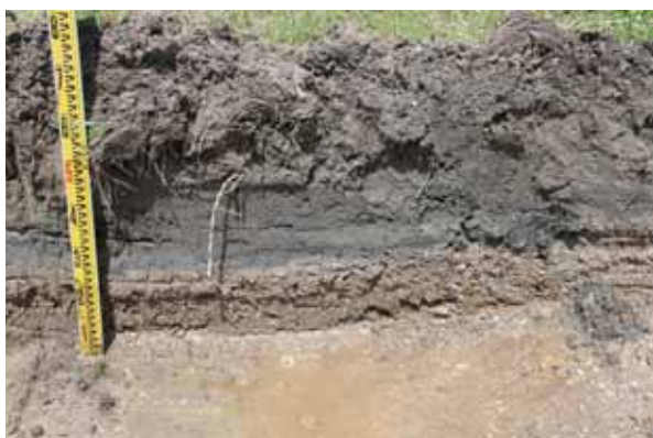
T10 トレンチ断面（南から）
