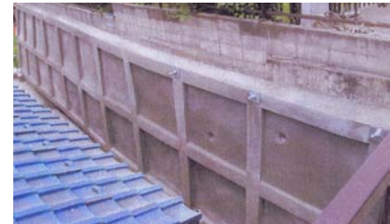
「擁壁の補強工」 泉沢町
