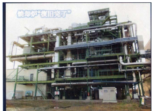
▲汚泥焼却施設の復旧 多賀城市大代
