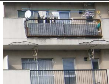
新浜町住宅 外壁→
