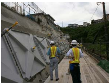
法面工事の施工状況確認（藤倉二丁目）
