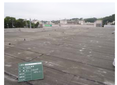
屋上にはソーラーパネルを設置します。
