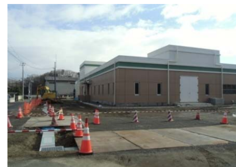
施工中の牛生雨水ポンプ場（芦畔町）
