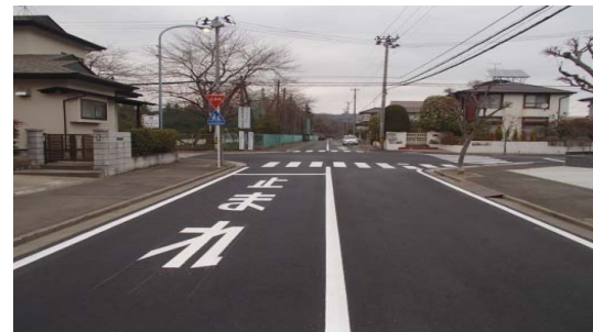
復旧された市道の路面（槻町）
