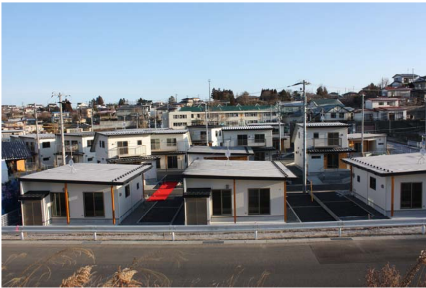
↑ 南側から伊保石地区災害公営住宅を望む。奥に見えるのは、ひまわり幼稚園。
