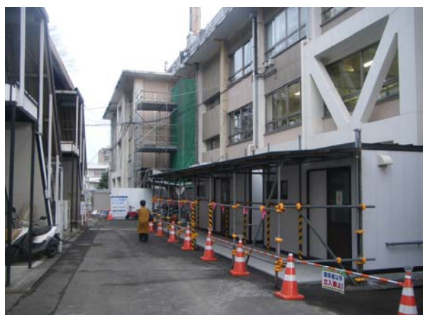
改修中の状況(奥)と仮設トイレ(手前右)
