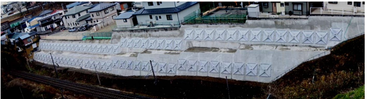
↑ 完成した法面の全景。手前はJR東北本線。
