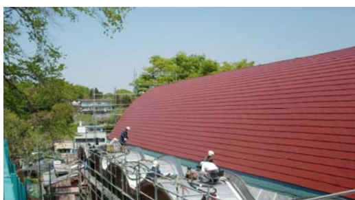
→ 大講堂の屋根工事
