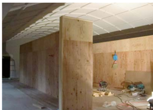
→ 2階展示室の工事
