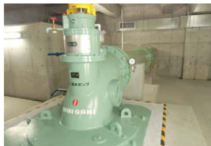
→ 場内の電動雨水ポンプ
