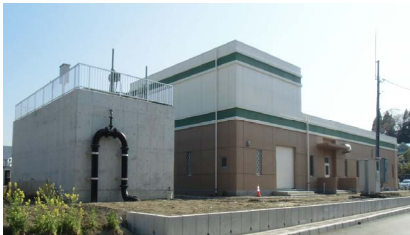
↑ 牛生雨水ポンプ場の外観
