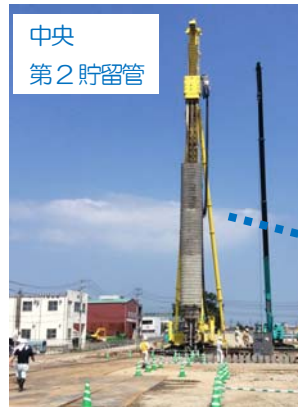
▲縦穴を構築するための重機(杭打機)
