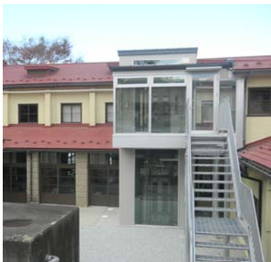
▼エレベーター
