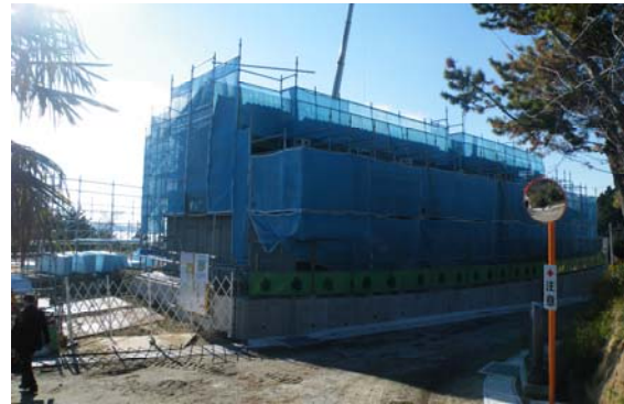
▼建設中の桂島災害公営住宅(12月8日撮影)
