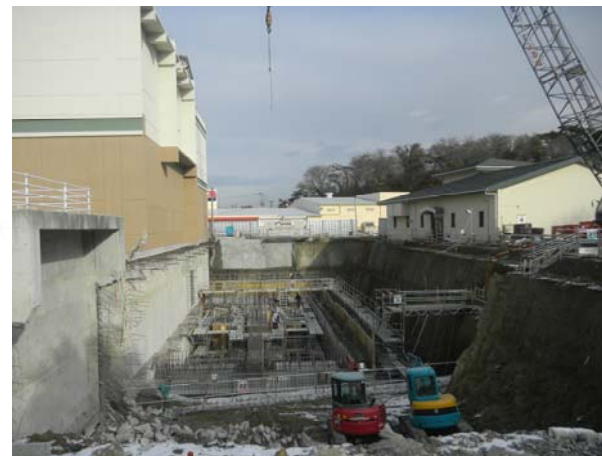
▼建築工事（12月24日撮影）
