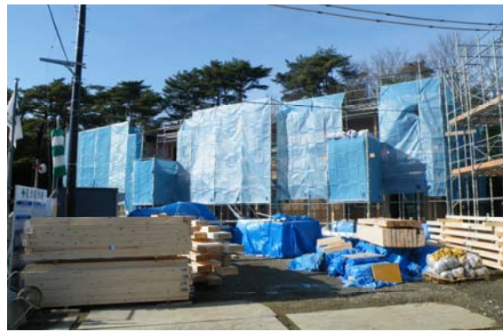
▼建設中の野々島災害公営住宅(12月21日撮影)
