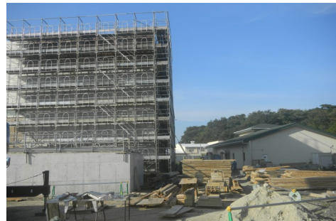
▲建築工事（9月28日撮影）
