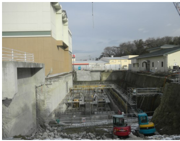
▲建築工事（平成26年12月24日撮影）
