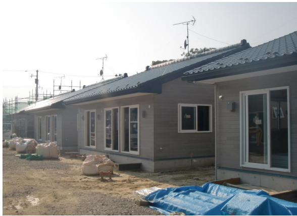
▲寒風沢地区災害公営住宅
