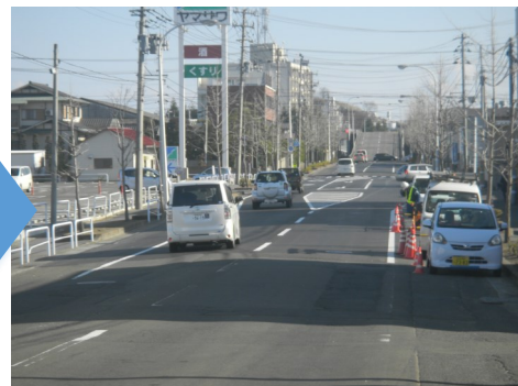
▲工事後（12月10日撮影）
