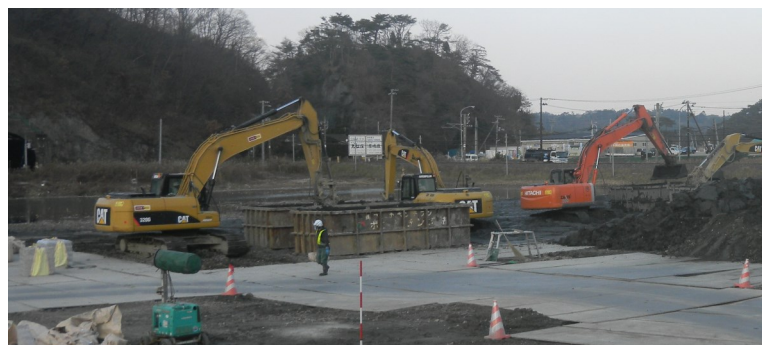
▲ショベルカーによる攪拌（12月22日）
