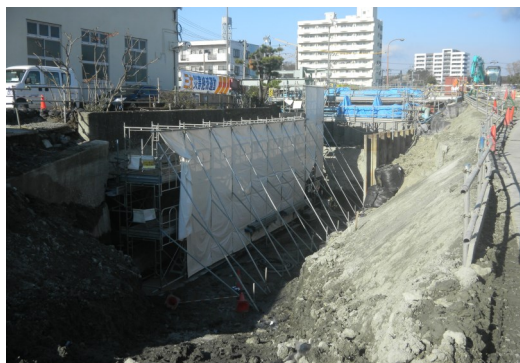
▲水槽築造のための掘削工事（12月17日）
