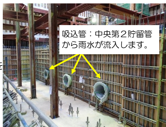
▲壁・柱型枠組立状況
