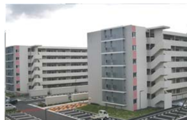
▼清水沢東災害公営住宅
