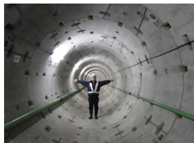
▲中央第2貯留管
