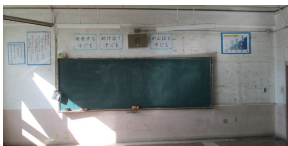
▶普通教室工事前
