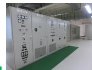
電気設備工事
