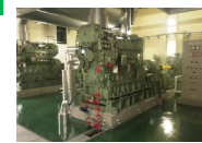
機械設備工事
