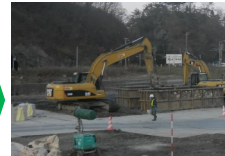
攪拌・浚渫作業
