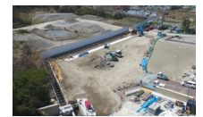
放流渠築造工事
