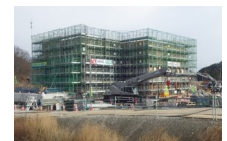
コンクリート打設工事
