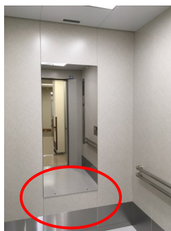
◀エレベーター内部
