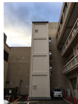
◀エレベーター外観
