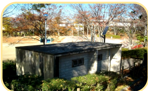
▲清水沢公園のトイレ（工事前）
