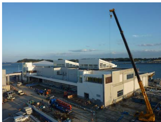
工事中の塩竈市新魚市場 (平成 29 年秋完成予定)
