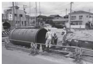
▲下水道(雨水)の埋設工事。直径1.8メートルの管を敷設します
