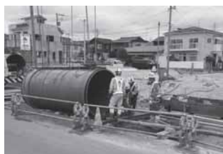
▲下水管(雨水)の埋設工事。 直径1.8メートルの管を敷 設します
