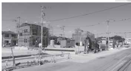
▲引き渡しが終わったところから、徐々に 宅地建築工事が始まっています
