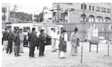
▲既存建物の除却(解体)工事に先立ち、安全祈願の清祓が行われました。
