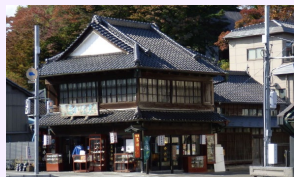
丹六園店舗兼主屋 (国登録 建造物)
