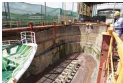
⑦ 東北ドック鉄工2号ドック
