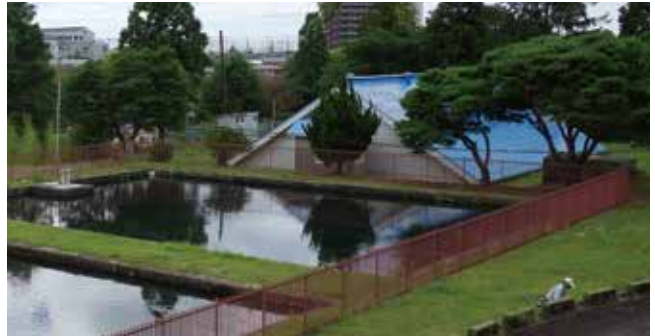
現在の権現堂浄水場
