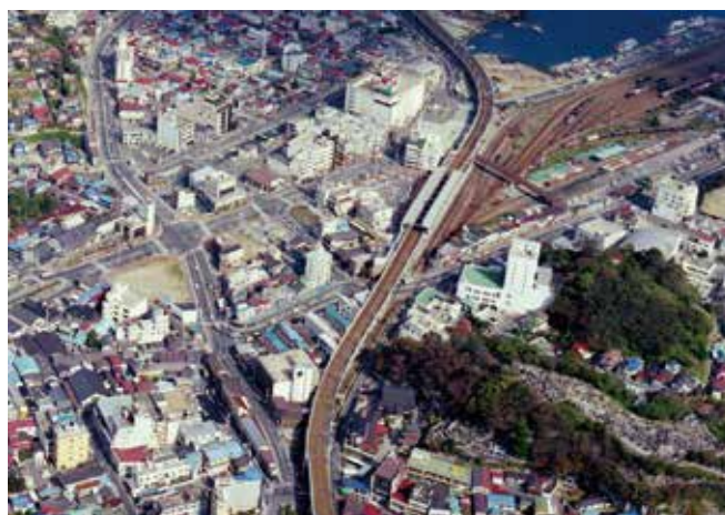
高架複線化された仙石線
