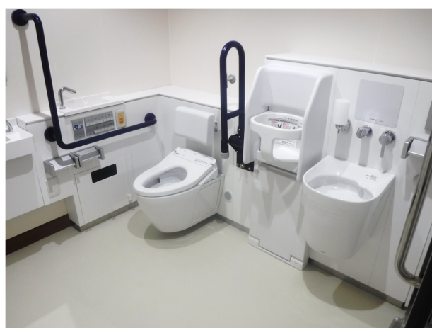
多目的トイレの設置（第二小学校）
