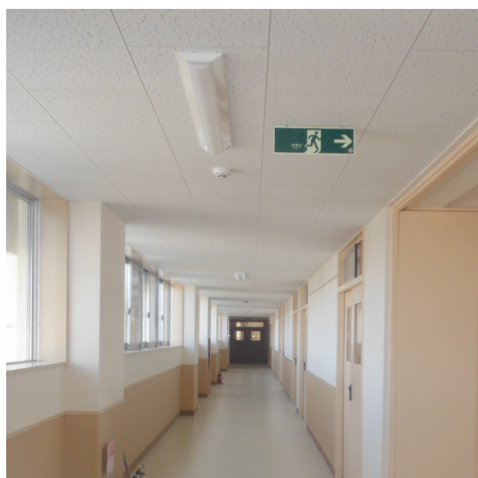
内部改修（第三中学校・廊下）
