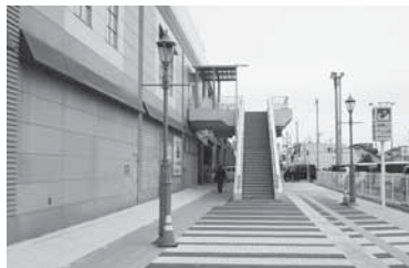
避難デッキへと続く「マリロードしおかぜ」
