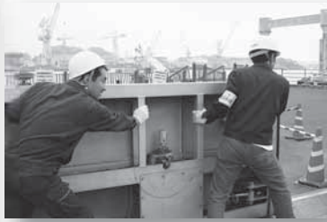
▲津波警報の発令を受け、市職員が防潮堤を閉鎖 (マリンゲート塩釜)
