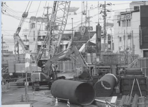
▲基礎杭の打設作業を進めています。完了後は、橋脚やデッキ本体の工事を進めます。
