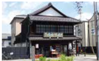
丹六園店舗兼主屋(国登録 建造物)
