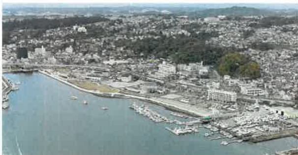
被災市街地復興土地区画整理事業が行われた北浜地区
