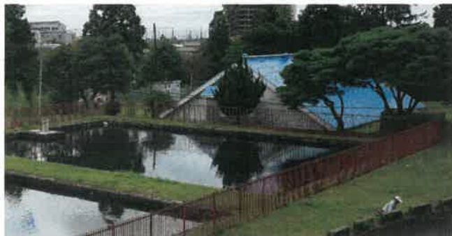
現在の権現堂浄水場
