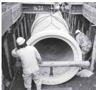
▲埋設作業中の雨水管
